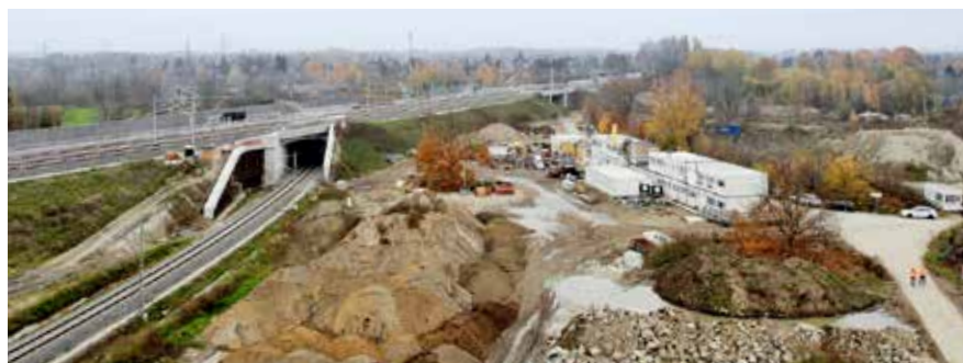
Am Karower Kreuz laufen bereits seit Dezember 2019 umfangreiche Bauarbeiten.
