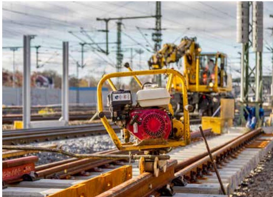
Baustelle mit Gleisbaumaschinen
