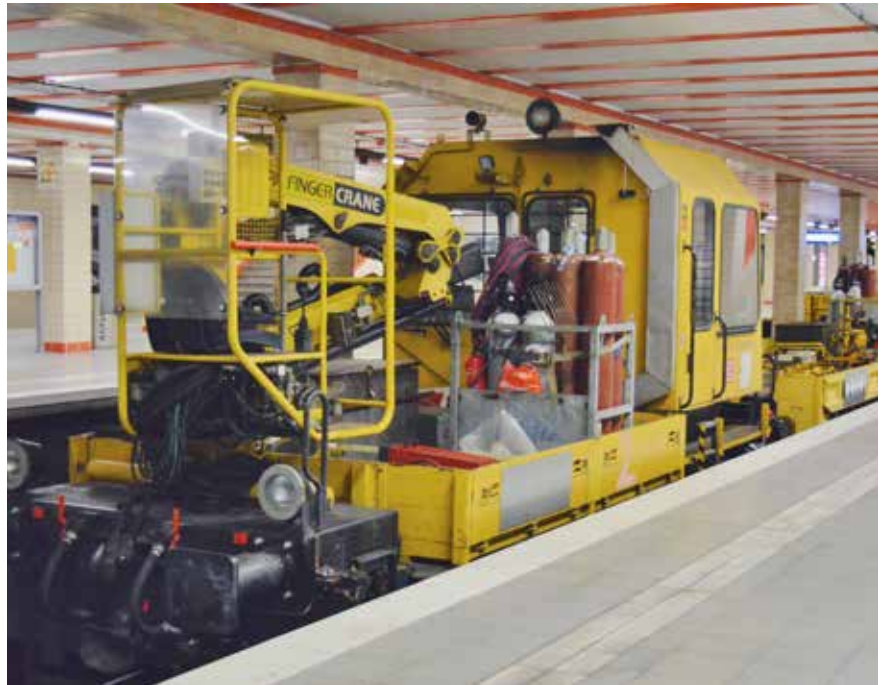
Gleisbauzug beladen mit Arbeitsgeräten
