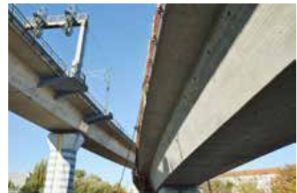
In Höhe des Spandauer Kanals unterquert die neue S-Bahn-Strecke (rechts) die Fernbahn.
