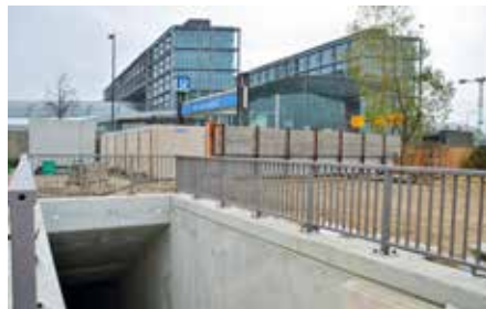
Einer der Zugänge zum neuen unterirdischen S-Bahnhof.
