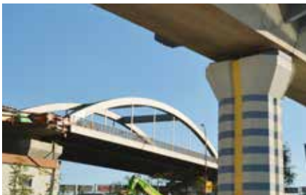
Neue Brücke für die S-Bahn an der Perleberger Straße. Im Vordergrund ein Pfeiler der bestehenden Fernbahn.
