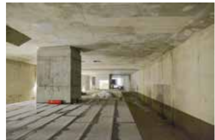
Blick in den neuen S-Bahnhof unter dem Hauptbahnhof.
