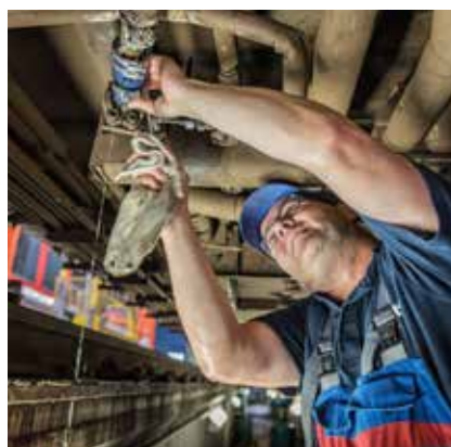
Die Hebebockanlage ermöglicht Arbeiten am Unterbau, etwa beim Austausch der Kühlflüssigkeit.
