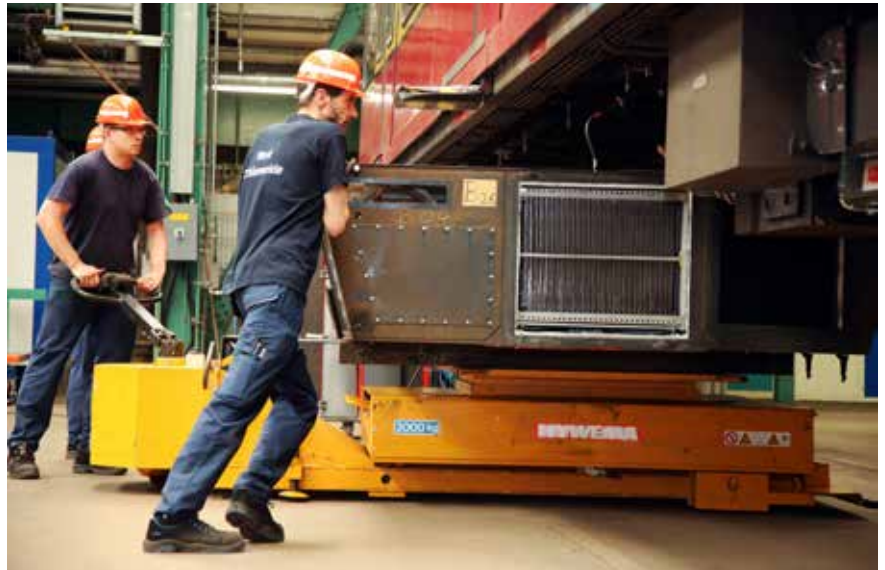
Am Viertelzug der Baureihe 480 wird ein Antriebscontainer mit neuer leistungsstärkerer Antriebstechnik eingeschoben.
