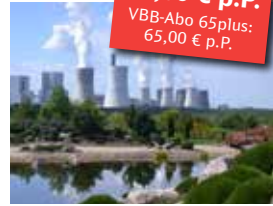
Foto: Foto: Kraftwerk Boxberg
