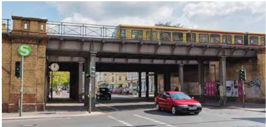
Die Eisenbahnüberführung in der Wollankstraße wird ausgetauscht.
