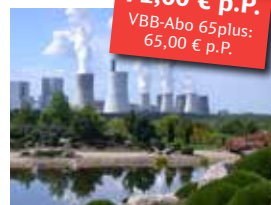
Foto: Foto: Kraftwerk Boxberg
